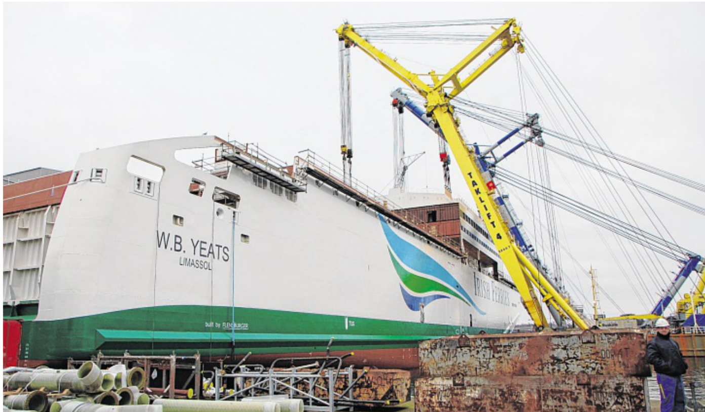
Millimeterarbeit: Gleich zwei Schwerlastkräne waren notwendig, um das 1500 Tonnen schwere Teil an Bord zu hieven. CHARLES DIRON
