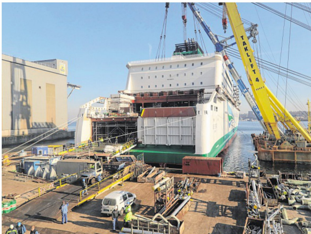
1500 Tonnen am Haken: Die beiden Kräne leisteten Schwerarbeit.
