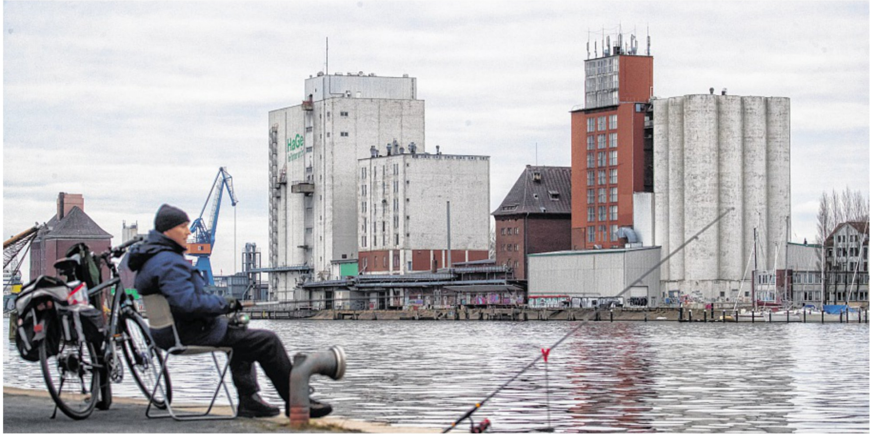
Industriedenkmal im Verfall: Das Hafen-Ostufer mit den Speichern und Silos steht vor einem grundlegenden Umbau.
